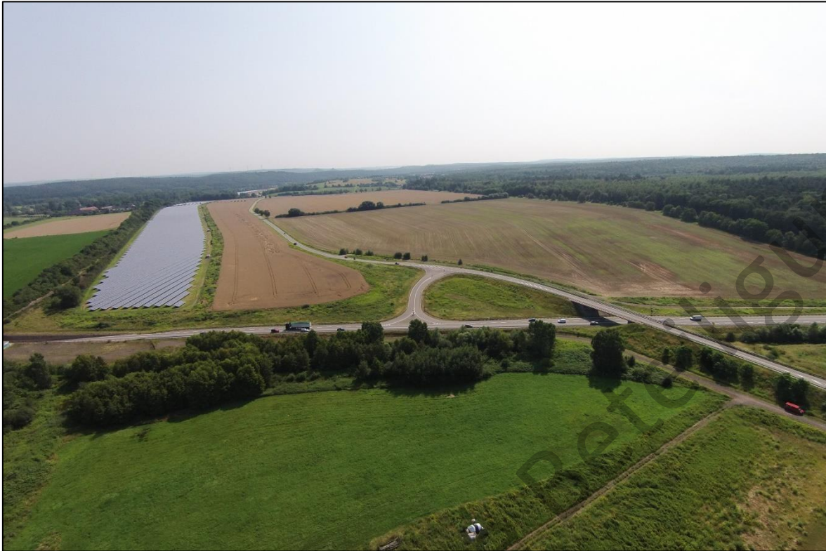
Abb. 6: Blick vom Nordwestrand des Untersuchungsraumes nach Osten. Die im Vordergrund quer verlaufende Straße ist die B269. Sie wird von der L168 überquert. Links sind die parallel zur Bahntrasse angelegten PV-Anlagen zu sehen. Direkt vor der B269 liegt ein Feuchtlebensraum.
